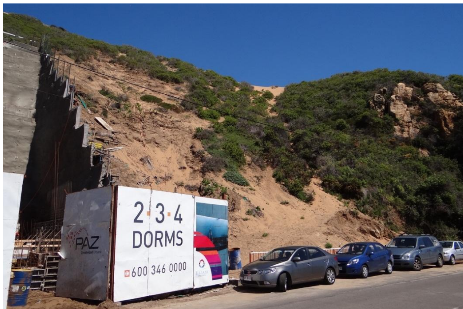
Figura 2-16 Desestabilización de talud
